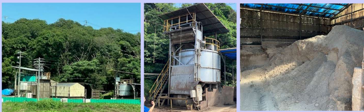
現地確認実施状況（産業廃棄物処理業者）
